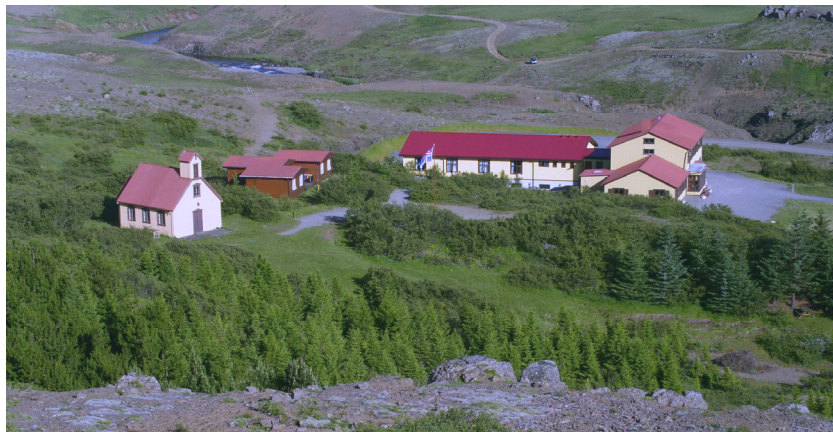
SUMARBÚÐIR KFUK Í VINDÁSHLÍÐ
